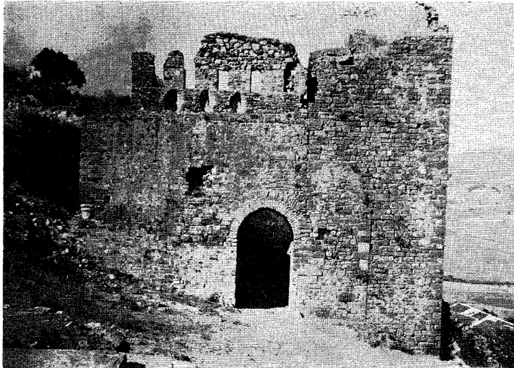
1.1.—Vista desde el interior de una puerta del recinto amurallado urbano, en la que se aprecia distintas etapas de construcción y reaprovechamiento de materiales hispano-romanos. (Fotog. Mora-Figueroa. 1970).
