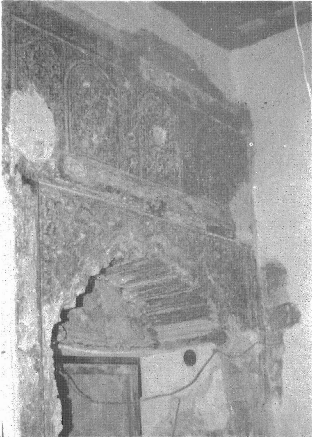
1.1.—Puerta con decoración de yesería.
