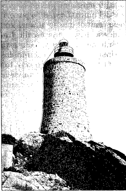
Lámina 7.- Torre de Cabo de Gracia o de Punta Camarinal (Tarifa). S. XVII. Rehabilitada en 1990 para su uso como faro por el Ministerio de Obras Públicas. La lámina no muestra la aparatosa escalera dispuesta por los ingenieros en la fachada opuesta.
