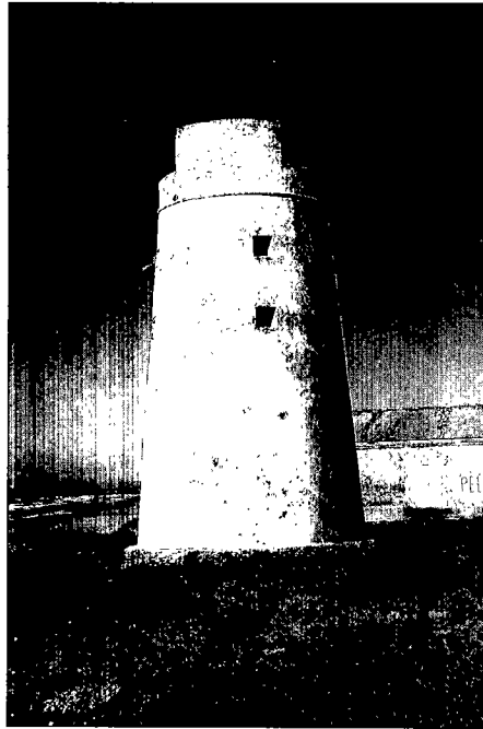
Lámina 5.- Torre Nueva (Vejer Fra.). Aunque su datación es dudosa, en cualquier caso posterior al s. XVII, su diseño sigue el patrón de 1616 referido en el texto. Ubicada en el borde de la playa de El Palmar se conserva en muy aceptable estado, merecedor de puesta en valor, y ello pese a la periódica invasión estival de bañistas. El recrecimiento del parapeto alberga la salida de la caja de la escalera.
