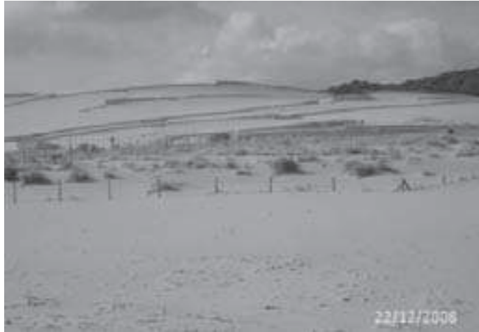
Figura 3. Instalación de captadores y revegetación
