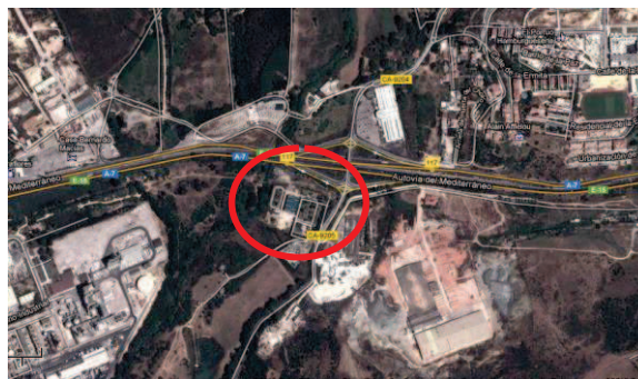
Fig.2. EDAR de San Roque
