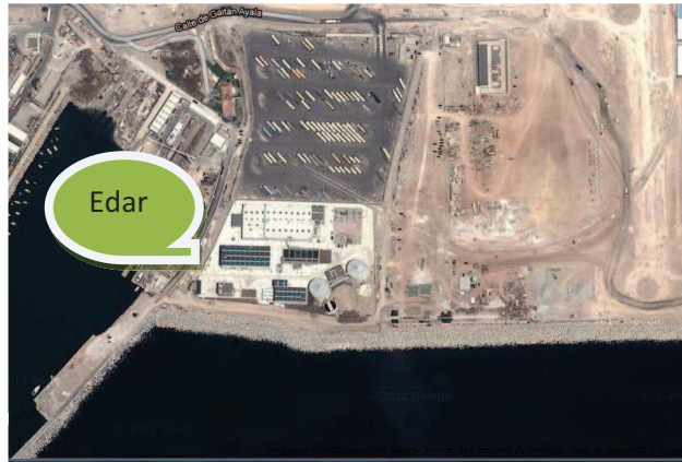
Fig. 1. EDAR de Algeciras
