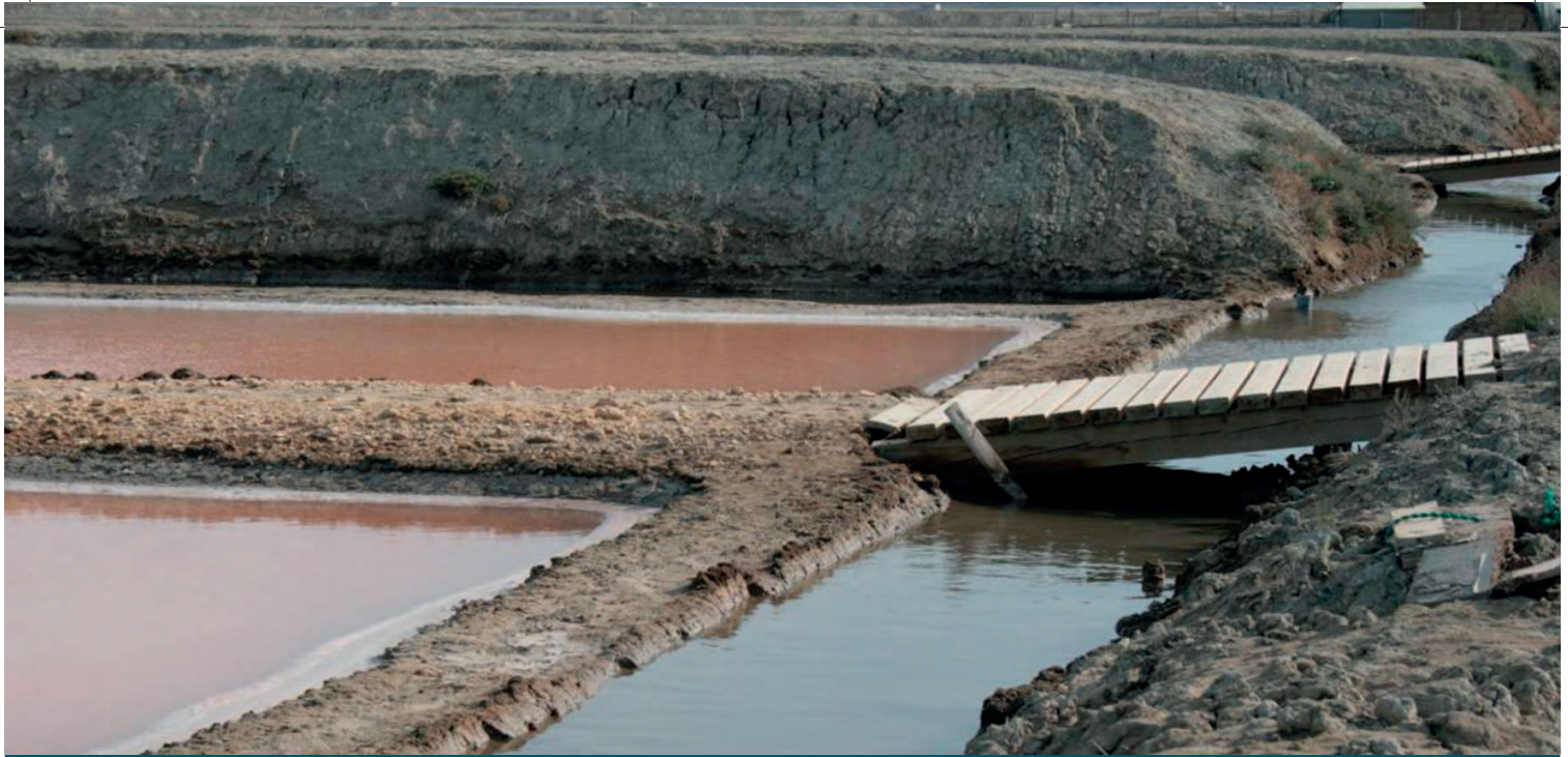
Figura 3: Detalle de los accesos a la madre de uno de los tajos de la salina Esperanza. Fuente: Demarcación General de Costas.
