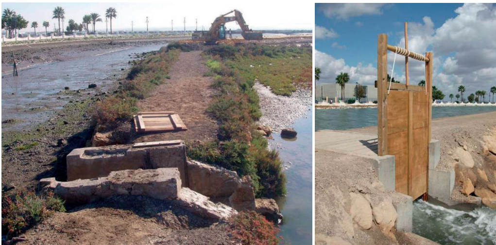
Figura 14: Vistas del estado anterior de las compuertas y estado final. Fuente: Demarcación General de Costas.
