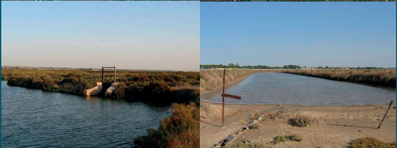
Figura 5: Imagen de la compuerta de la Esperanza Grande y nave de cristalizadores de la Esperanza Chica. Fuente: Demarcación General de Costas.
