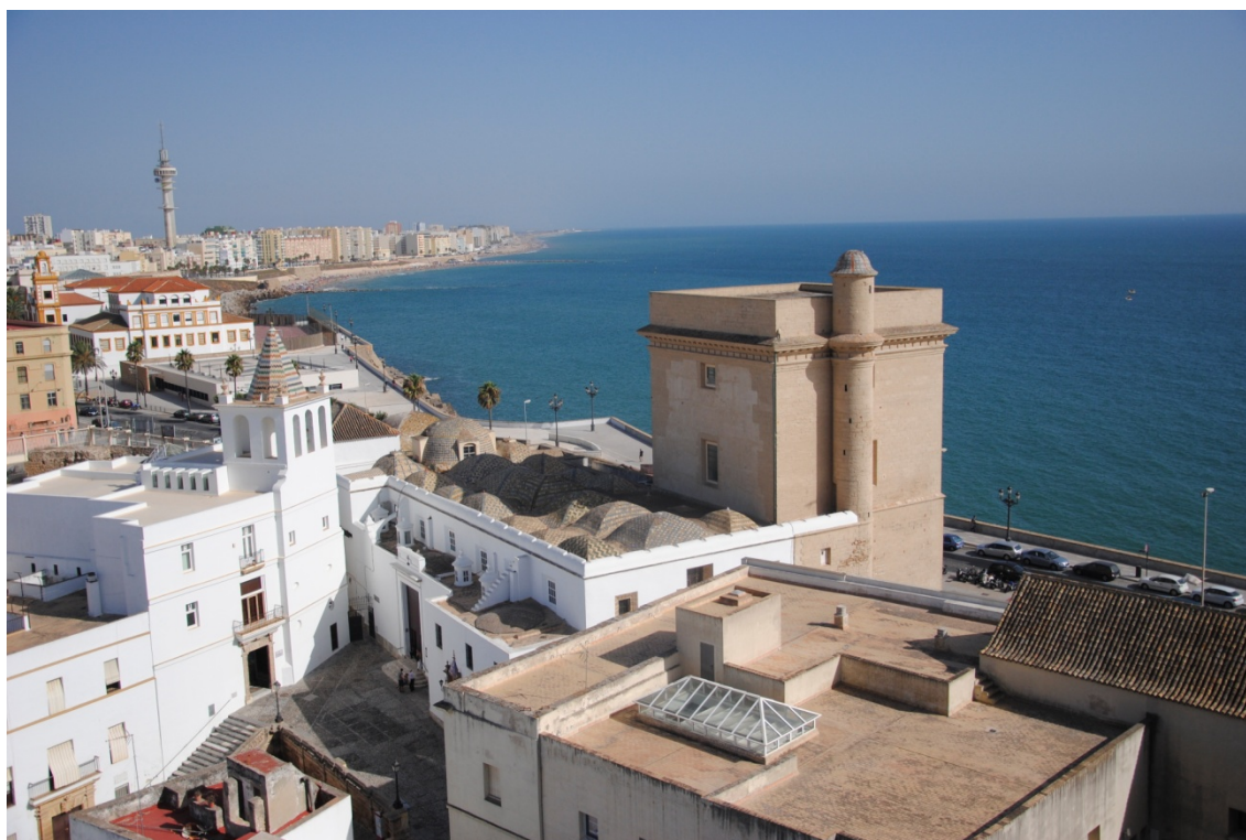
Ilustración 24. Torre del Sagrario y techo de la Iglesia de Santa Cruz desde la Catedral Nueva. Antonio García
