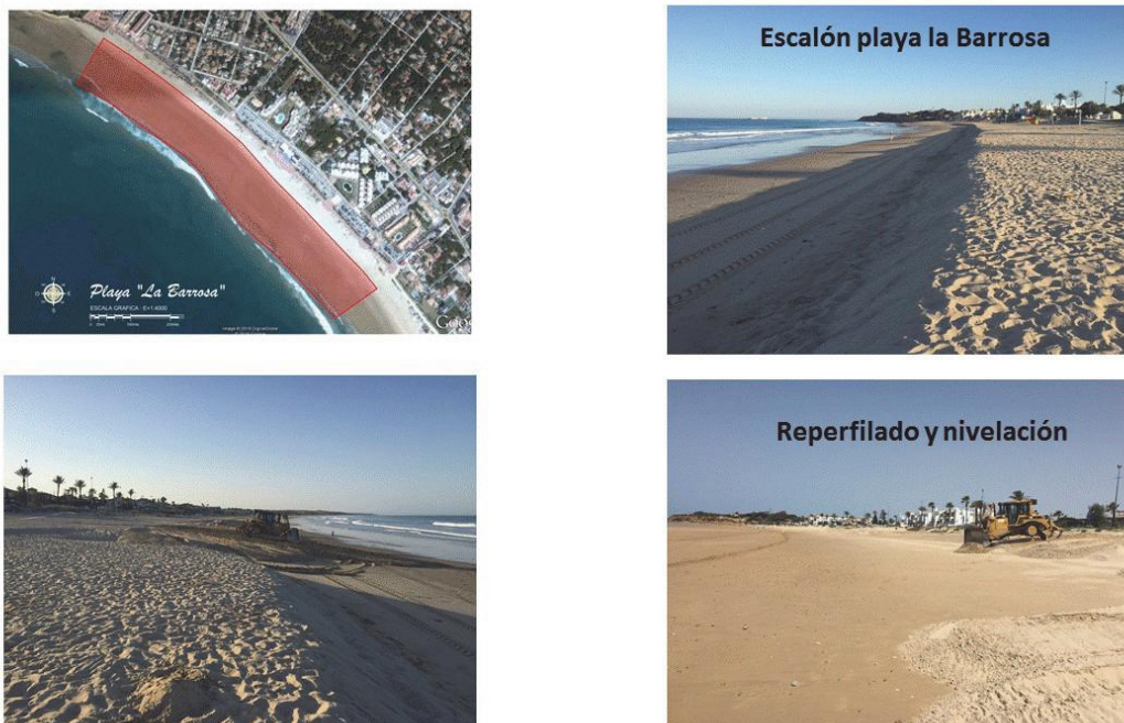
Fig. 11. Ejecución de trabajos en la Playa de La Barrosa (T.M. Chiclana))
