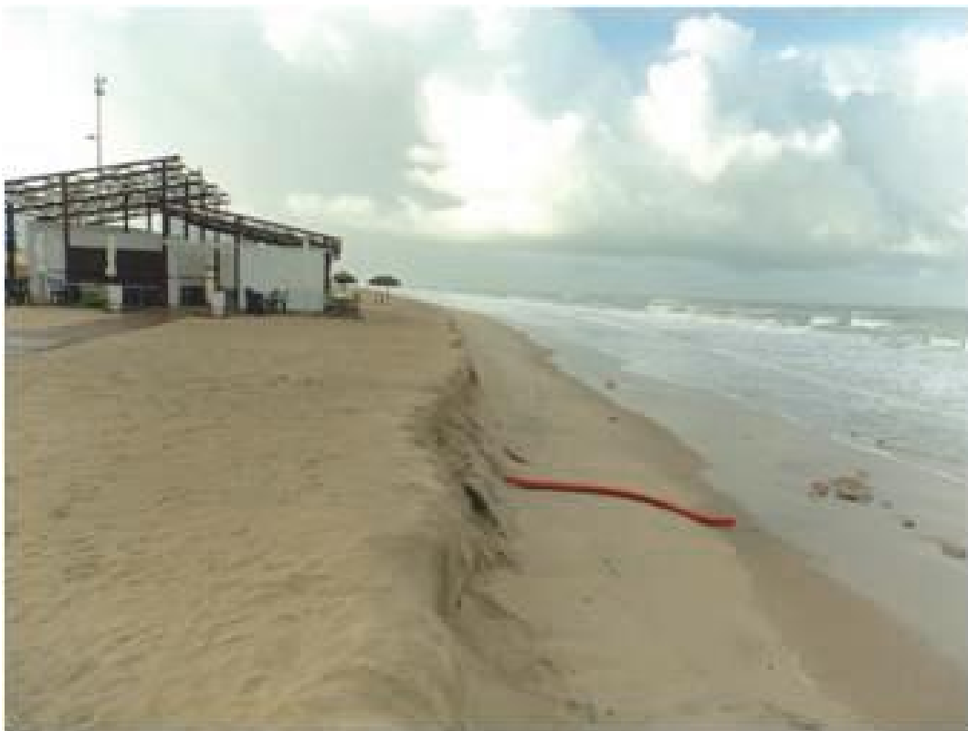
Fig. 4. Foto de la erosión en la zona norte de la Playa de La Victoria
