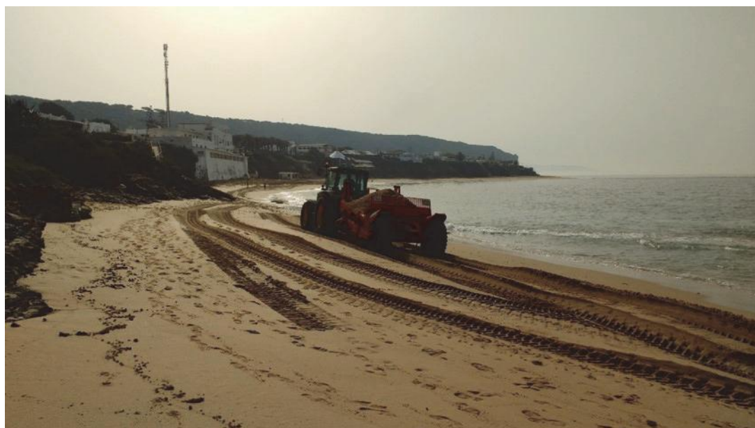
Fig. 12. Ejecución de trabajos en la playa de los Caños de Meca (T.M Barbate)
