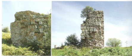
Lám. 42a. Sillares romanos, Torre de Gibalbín (AGL).
