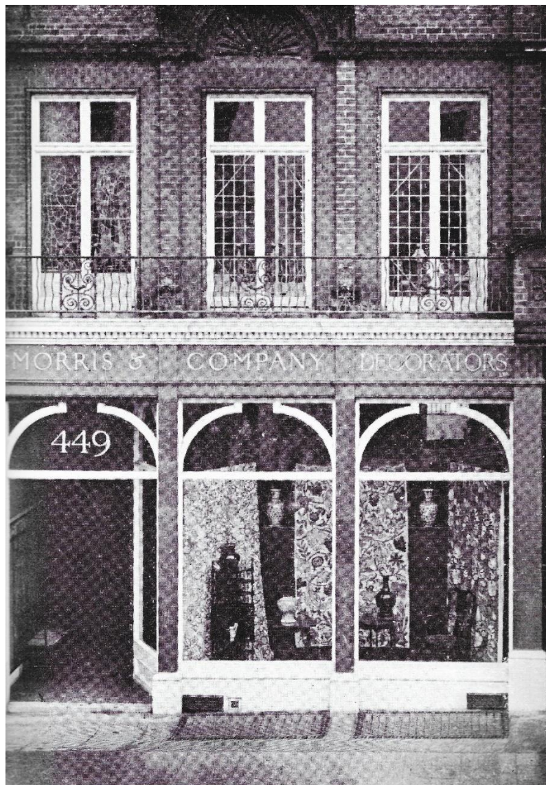
Figura 6. Fachada tienda Morris & Co. N° 449 Oxford Street, 1879. Fuente: W. Morris & Co., p.250.
