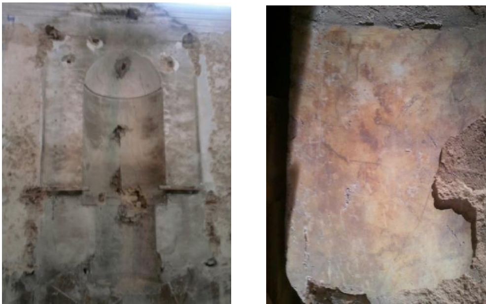
Fig. 1 (esq.) y 2 (dir.) - El muro de la Capilla tras retirar uno de los retablos laterales, 2011. F.A.; únicos restos de policromía mural encontrados en el altar mayor. Interior de la hornacina, 2011. F.A.
