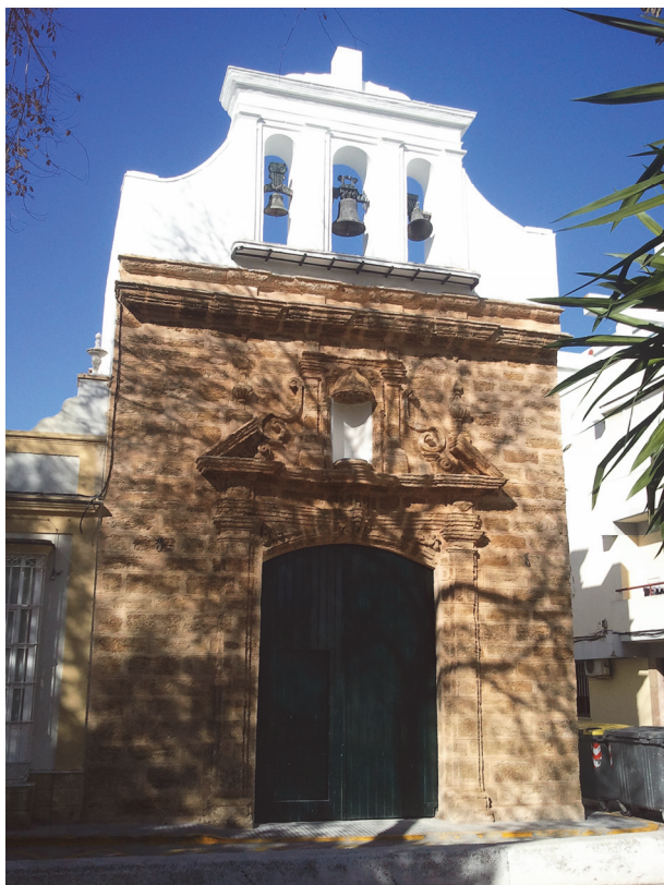
Figura 8. Fachada tras la restauración.
