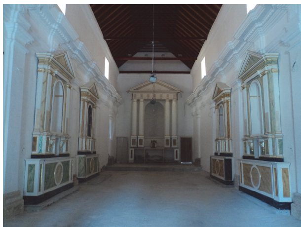
Figura 13. Interior tras la rehabilitación.
