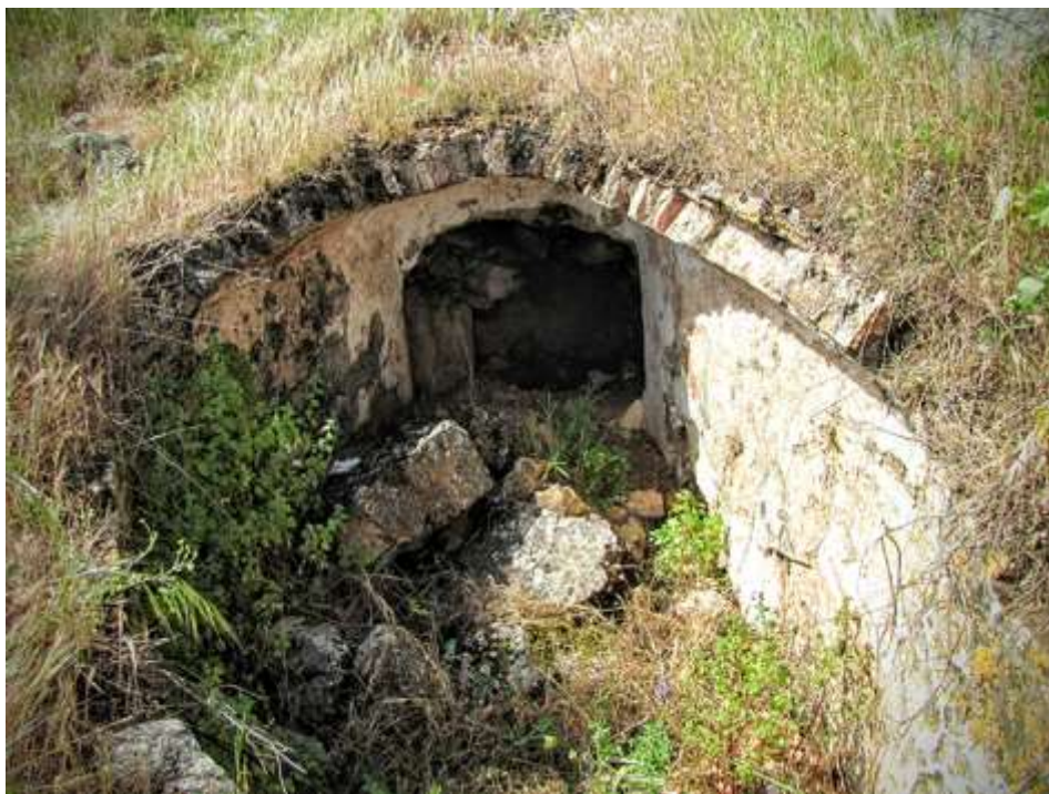
FIGURA 5: Gruta excavada en Arroyo de San Serván.
