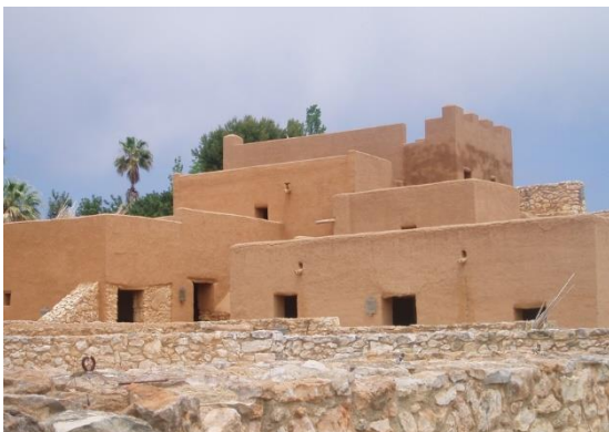
Figura 5 Reconstrucción total en la ciudadela ibérica de Calafell
