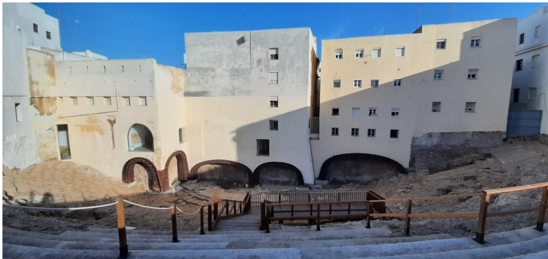
Figura 16 Vistas del Centro de Interpretación y viviendas desde la cavea.
