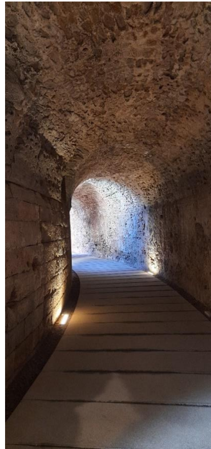
Figura 14 Galería anular del Teatro Romano de Cádiz
