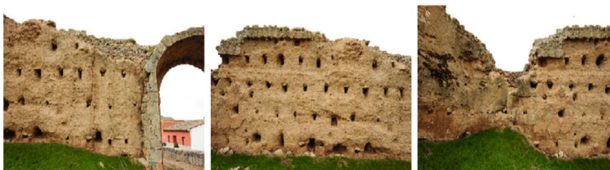
Figura 14. Ejemplo de toma fotográfica paralela de lienzo de muralla y puerta del Castillo de Villagarcía de Campos (Valladolid) (García, 2015: 49).
