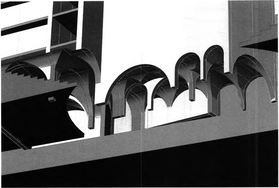
Figura 14. Imagen del sistema de bóvedas y pilastras bajo los edificios existentes. La cavea aparece seccionada a la izquierda
