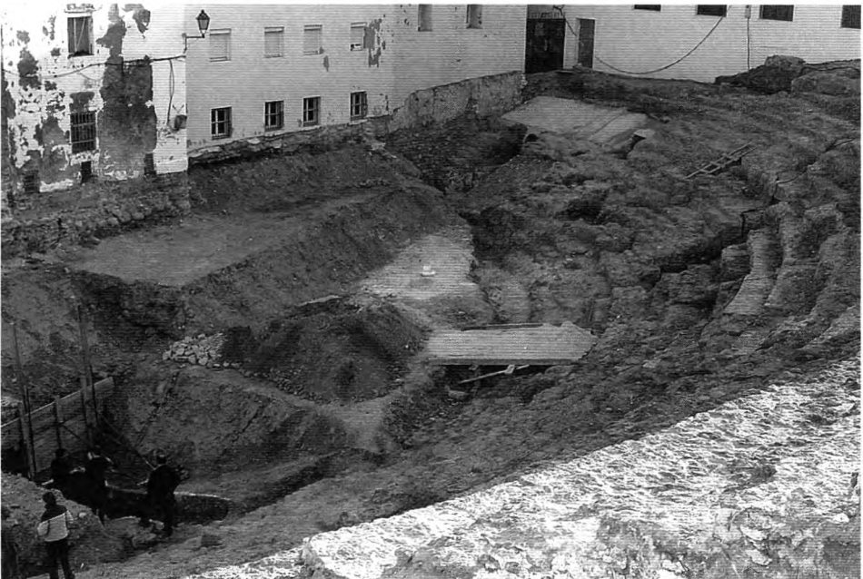
Figura 19. Limpieza y perfilado de tierras (años 2000–2001)
