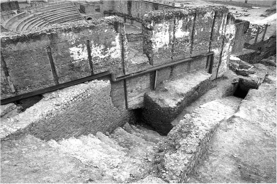
Figura 6. Vista de la escalera monumental descubierta
