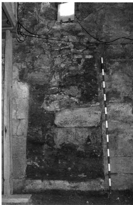
Figura 29. Detalle del vomitorium occidental desde la galería radial, y de su colmatación interior
