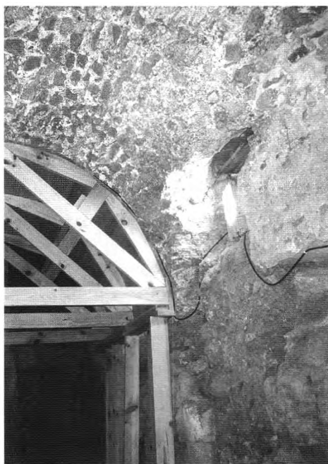
Figura 33. Vista del 4º vomitorio, pendiente de excavación
