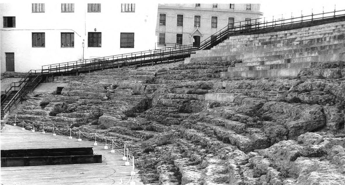
Figura 38. Pasarela de acceso al monumento
