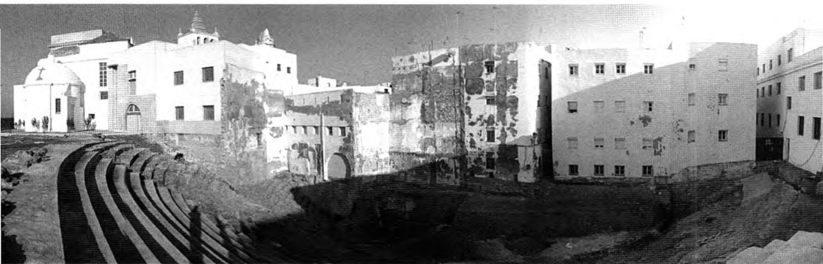
Figura 1. Vista panorámica del Teatro Romano de Cádiz, con las edificaciones objeto de consolidación
