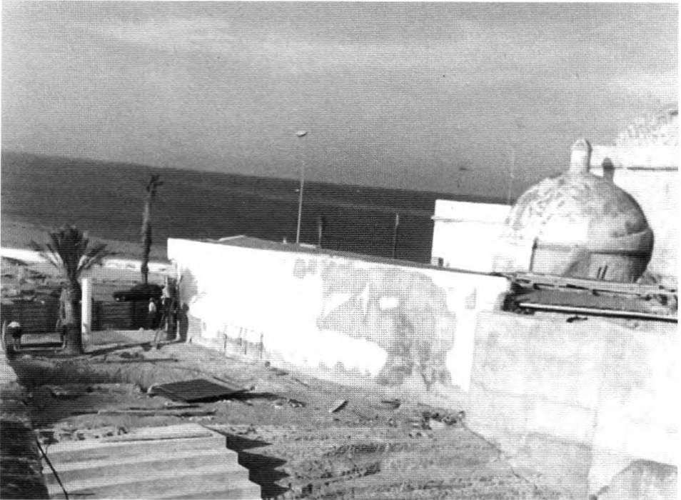
Figura 16. Muro de separación con la Catedral Vieja
