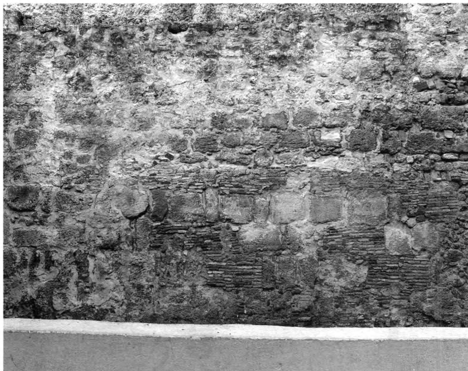
Figura 17. Detalle de elementos arquitectónicos en biocalcarenita reutilizados en el paramento medieval del Castillo de Cádiz, en el tramo recientemente restaurado, paralelo a la calle San Juan de Dios
