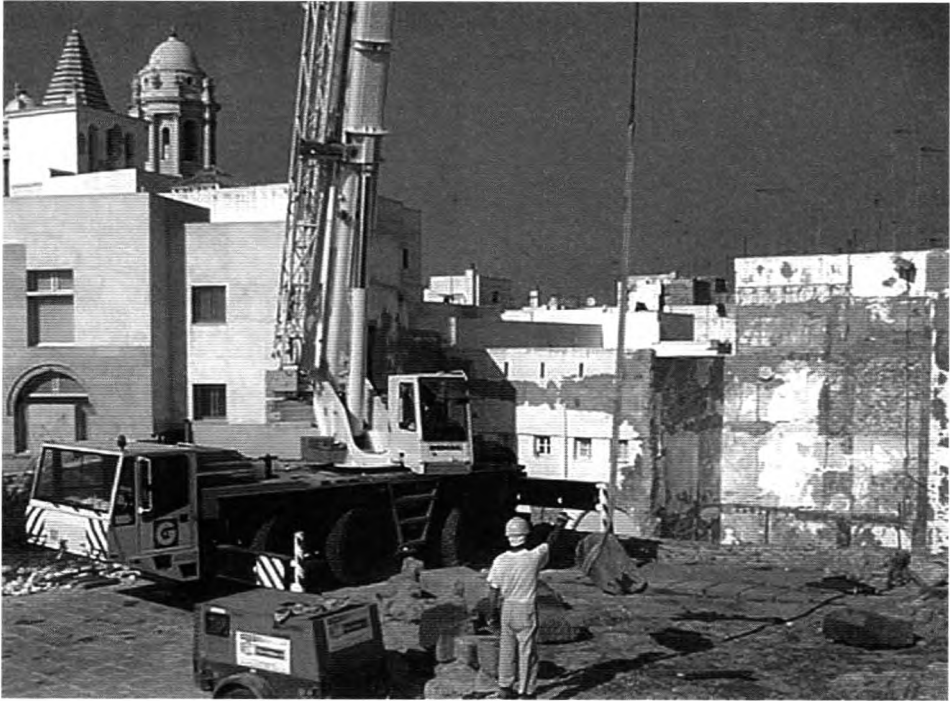
Figura 18. Proceso de reubicación de sillares
