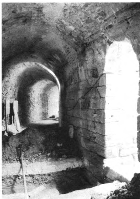
Figura 34. Detalle de la cata en el interior de la galería
