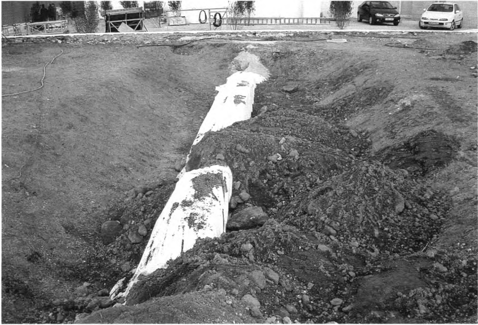
Figura 39. Proceso de cubrición del muro del siglo xvii
