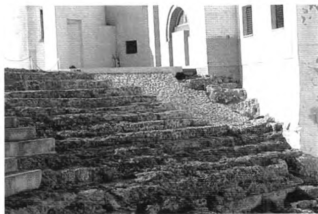
Figura 21. Detalle del tratamiento del graderío
