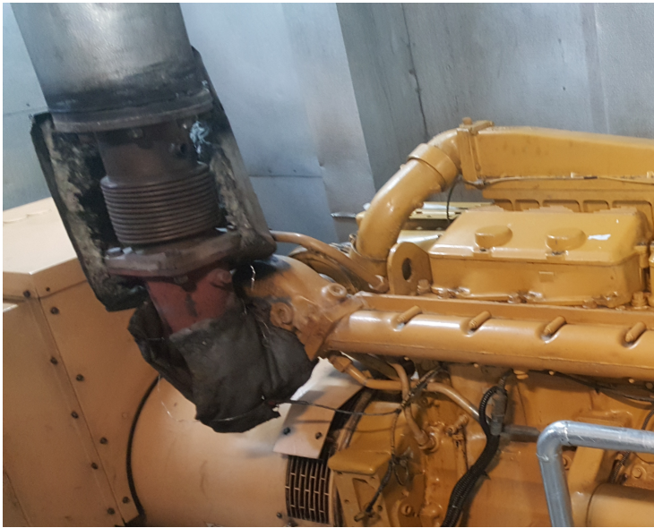
Figura 12. Motor B vista colector de gases de escape Fuente: Elaboración propia
