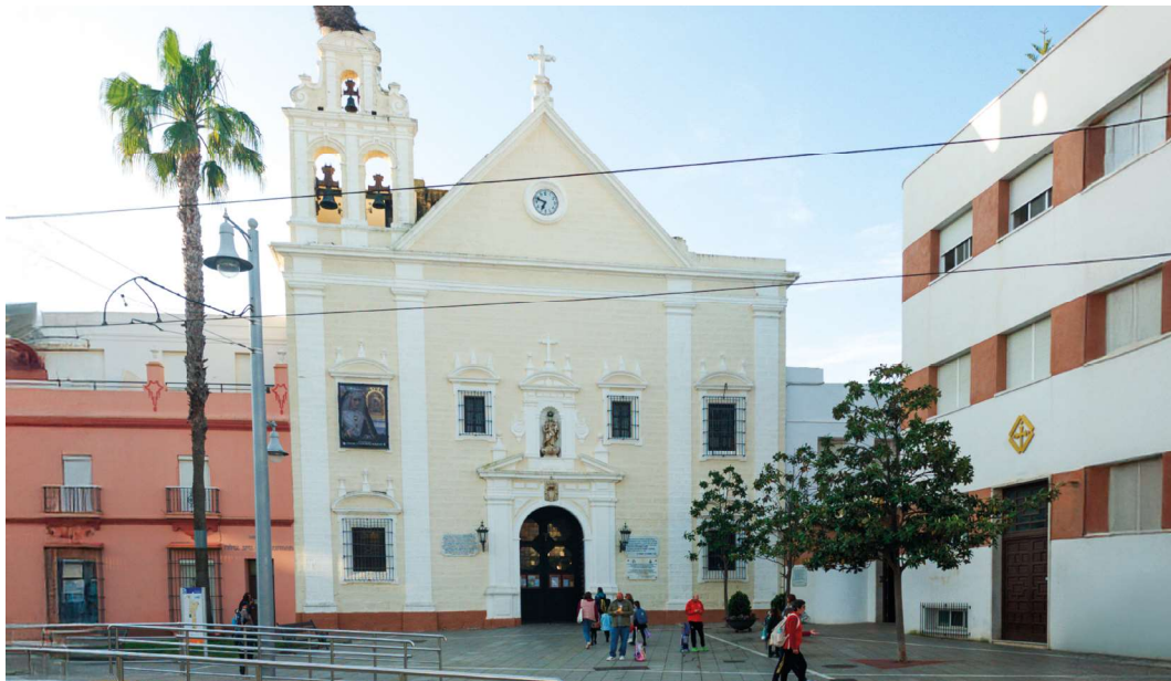
Figura 2 - Fachada de la iglesia del convento del Carmen. Fuente: fotografía del autor.
