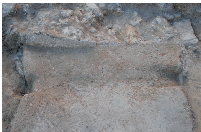
Figura 5. Revoco conservado del interior de una de las piletas romanas documentadas en la calle Convento N.º 11-13 en opus signinum . © Juan Antonio Cerpa Niño.
