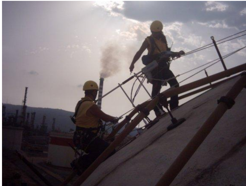
Ilustración 4.6 Imagen de la empresa La Línea Vertical en el exterior de un tanque de esfera
