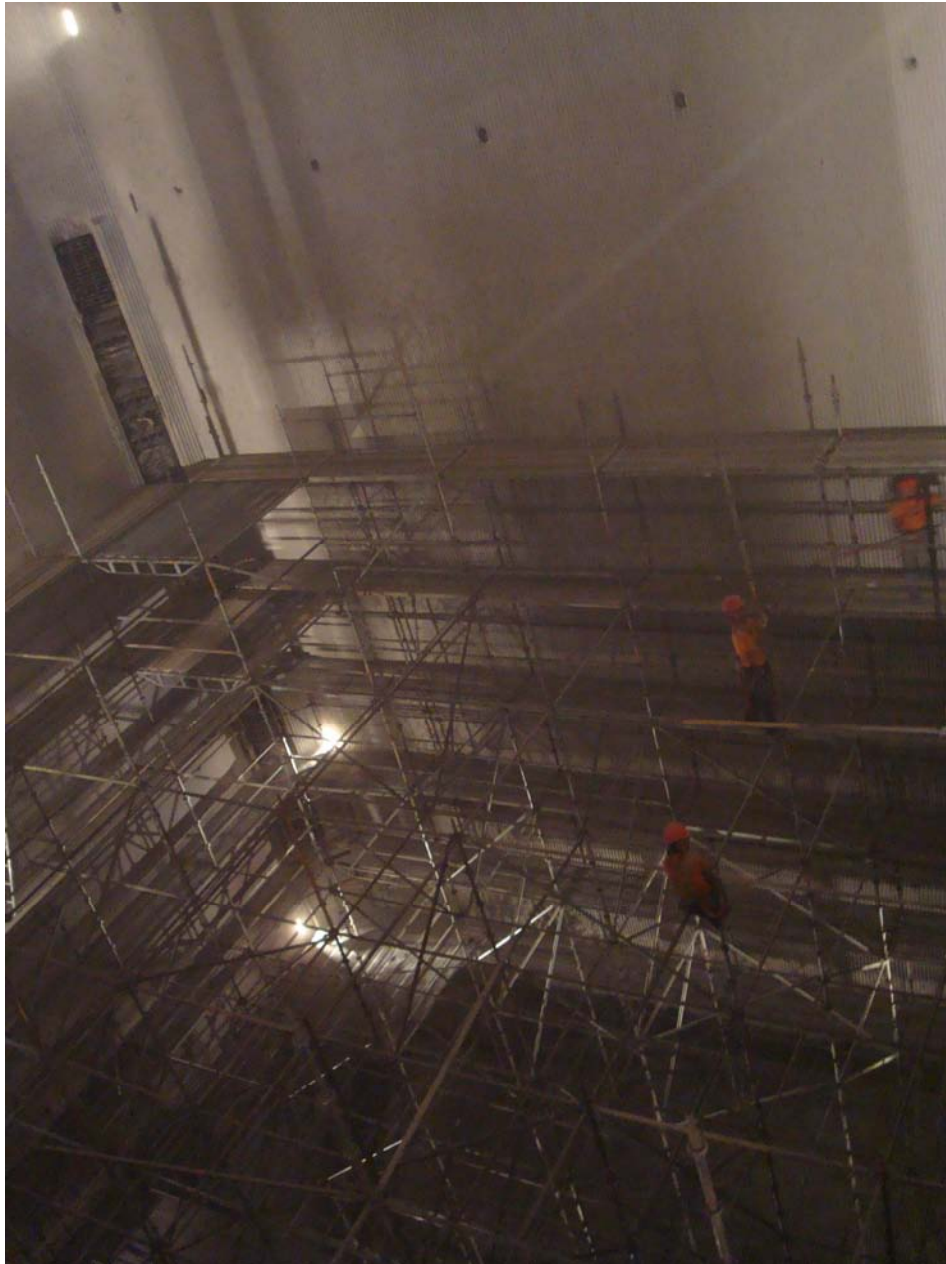
Ilustración 5.6 Interior de un horno de una central eléctrica. Trabajadores montando un andamio de casi 60 m de altura
