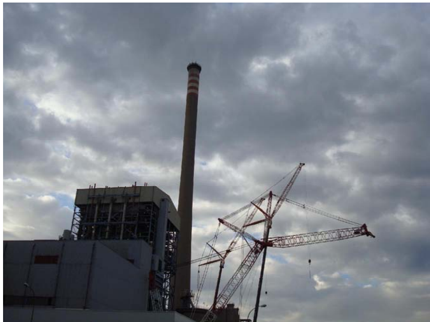
Ilustración 2: Chimenea de hormigón
