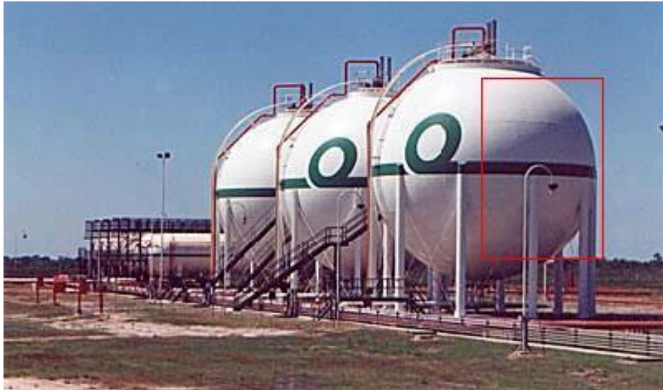
Ilustración 14: Zonas de trabajo de mantenimiento en tanques de esfera
