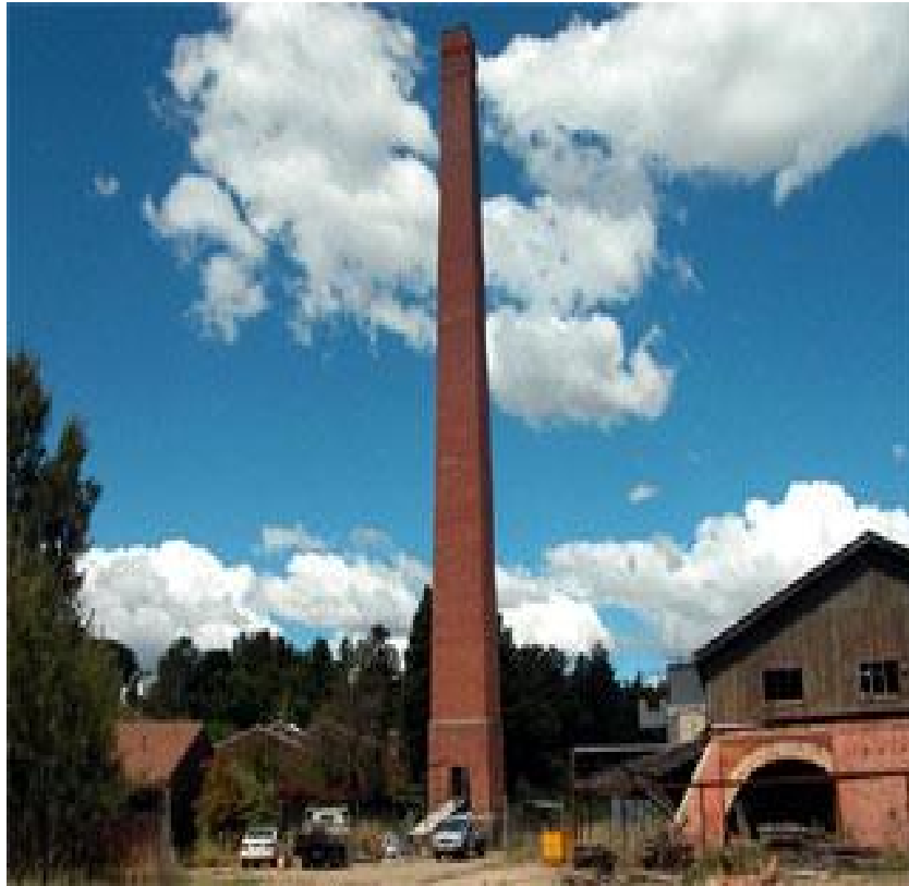
Ilustración 1: Chimenea de ladrillo
